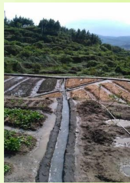
修復被颱風破壞的灌溉系統
