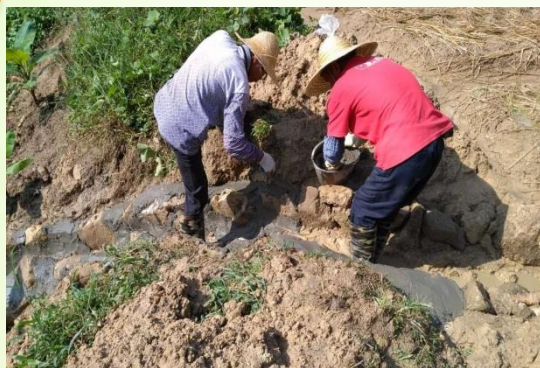
修葺及加固斜坡
