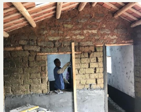
坭房子復修工程進行中
